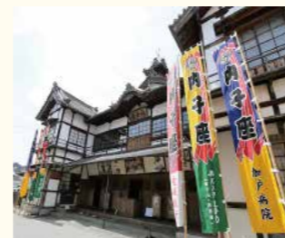
大正5年に創建された芝居小屋「内子座」の外観
