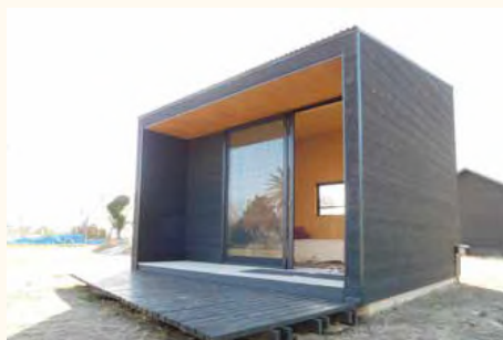
旧校庭に並ぶ「小屋」の外観
