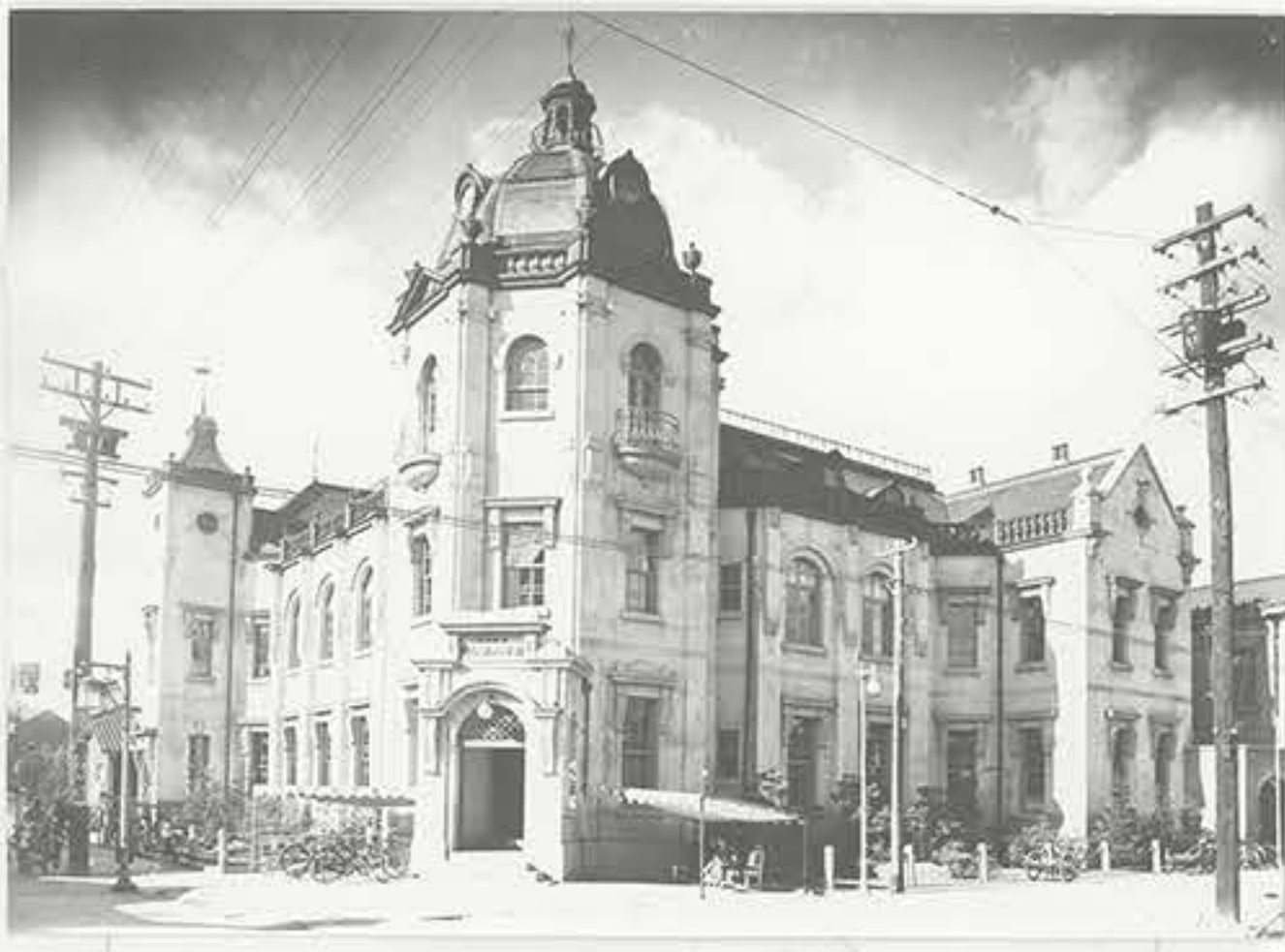
1936年 外壁が白色に塗られていた
