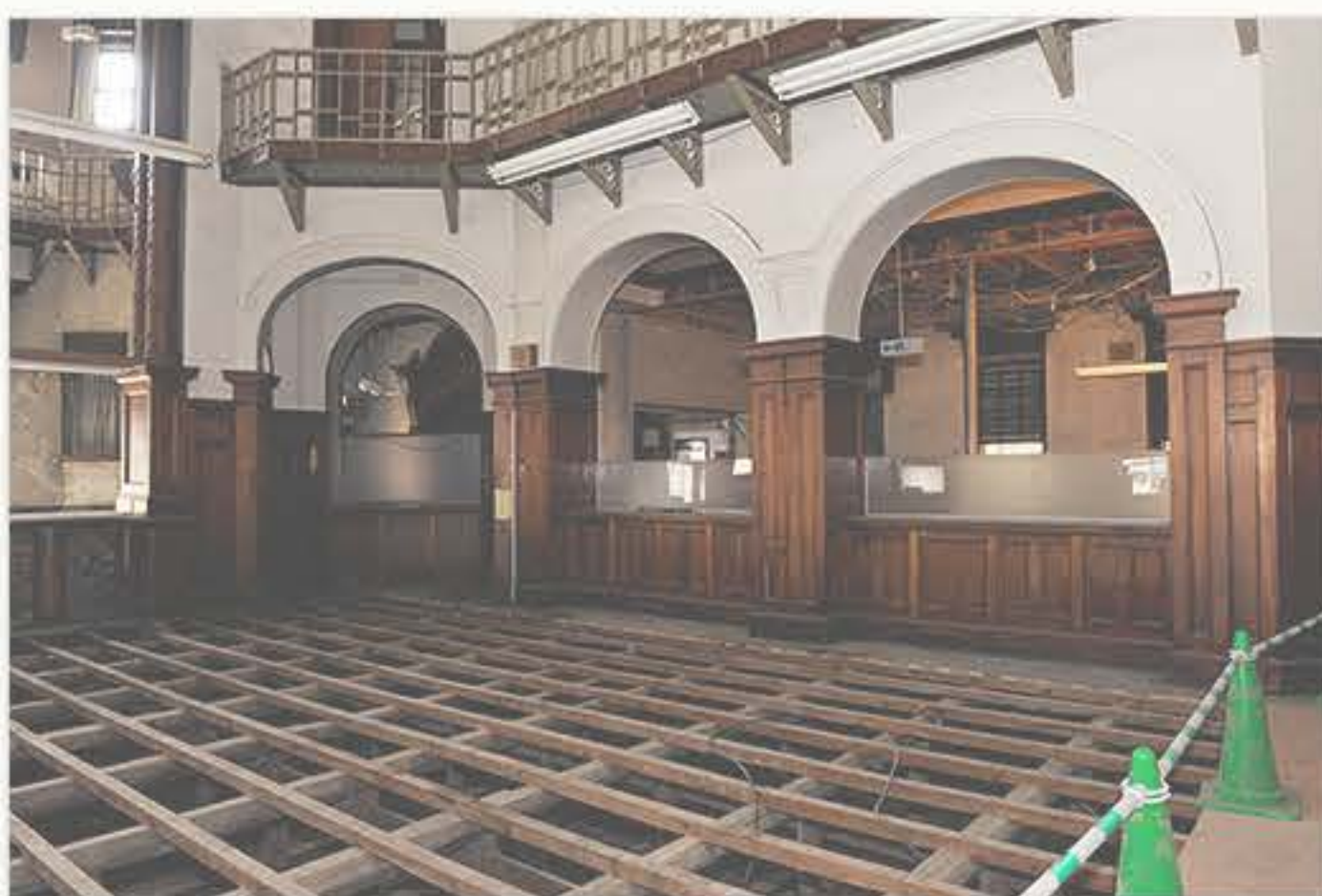
2012年 営業終了後、公開施設のために復元工事を開始
